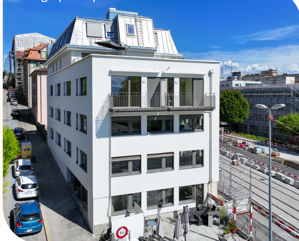
Photographie après travaux de l'immeuble
