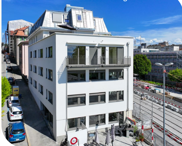
Nach den Renovationsarbeiten fotografiert
